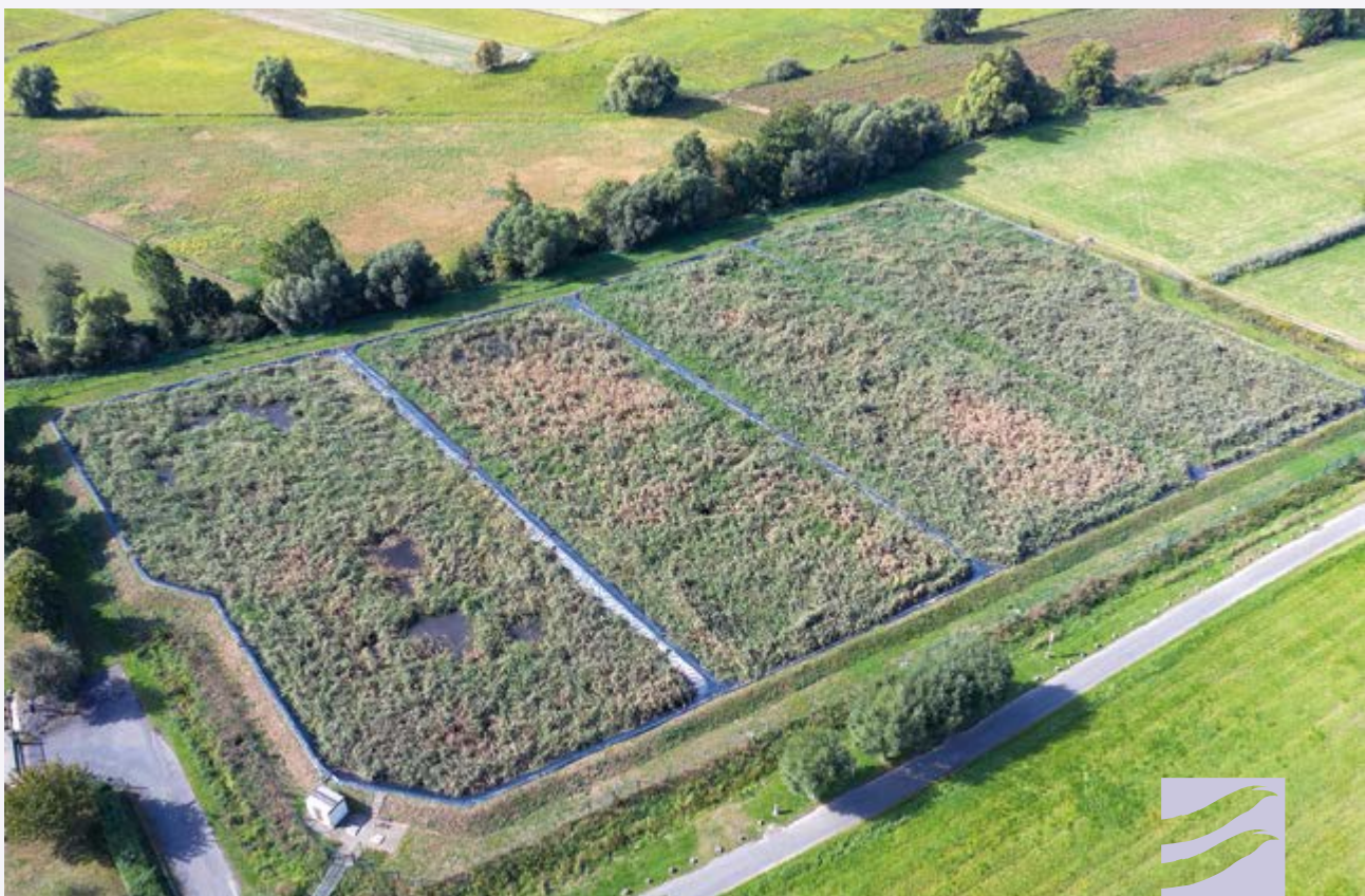
Klärschlammvererdungsanlage Vier Beete der Vererdungsanlage liefern nach mehreren Jahren Erde die Humusprodukten ähnelt
