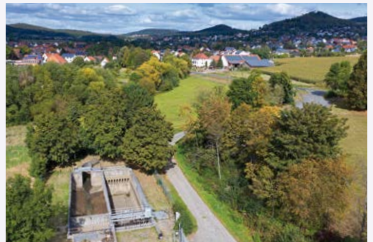
Wichdorf Außenbauwerk mit Stau und Drosselung
