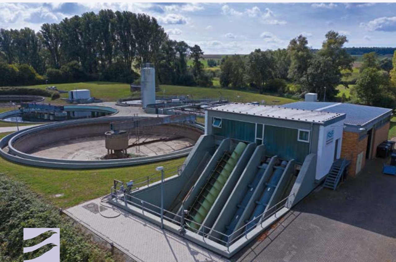
Betriebsgelände Vorpumpwerk mit Schnecke
